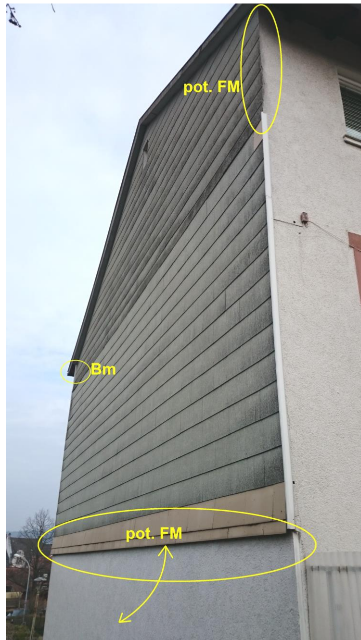
Foto 5.: Südwestfassade von A2 (Haus Nr. 13): Links im Bild in der Nähe des Dachüberstands konnte aufgrund des Anflugs und der Rufe ein besiedeltes Nest einer Blaumeise nachgewiesen werden. Der Abbruch darf daher nur außerhalb der Brutzeit oder nach Freigabe durch einen Gutachter nach Ausflug der Gebäudebrüter erfolgen. Hinter den Schindeln befinden sich Spalten, die Einflüge von Spaltenfledermäusen erlauben. Es sind daher Quartiermöglichkeiten vorhanden (v.a. Sommer-, aber auch Zwischen- und u.U. Winterquartiere). Daher sind die Schindeln manuell und nur außerhalb der Wochenstuben- und Winterquartierzeiten – vorzugsweise im Oktober - im Beisein einer Ökologischen Baubegleitung (ÖBB) abzudecken (s. Kap. 3.1. ).
