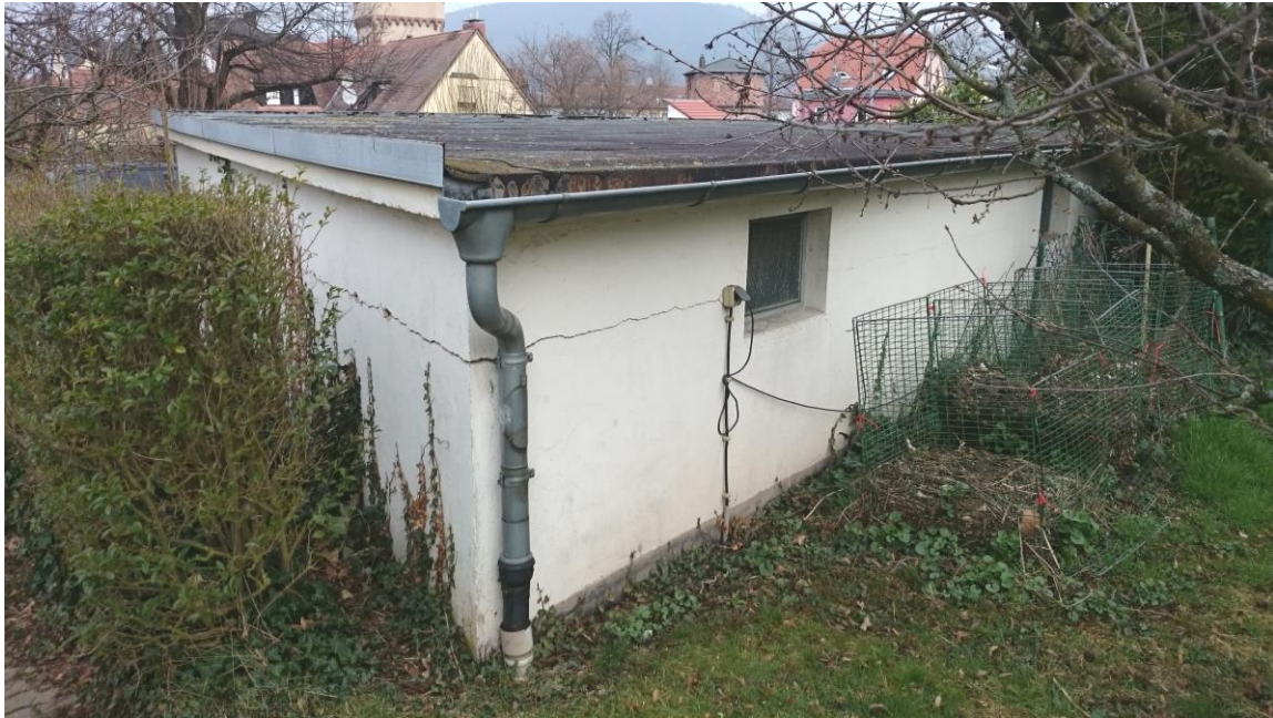
Foto 3.: Die Fenster auf der Rückseite der Doppelgarage A1 sind intakt und verschlossen. Auch das Pappdach ist ohne Befund.
