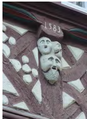
Detail im Fachwerk
