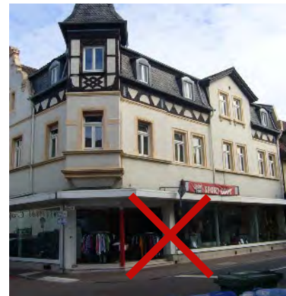
Gestörte Fassade im Erdgeschoss
