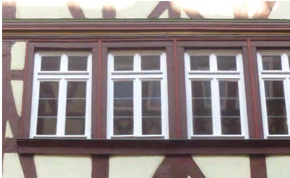
Holzfenster im Fachwerk
