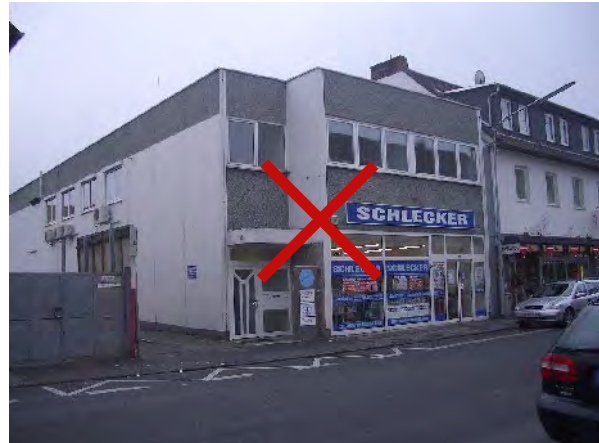
Nicht zulässig: Gebäude mit Flachdach
