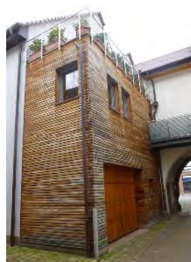
Als Abweichung zulässig: Flachdachanbau als Terrasse
