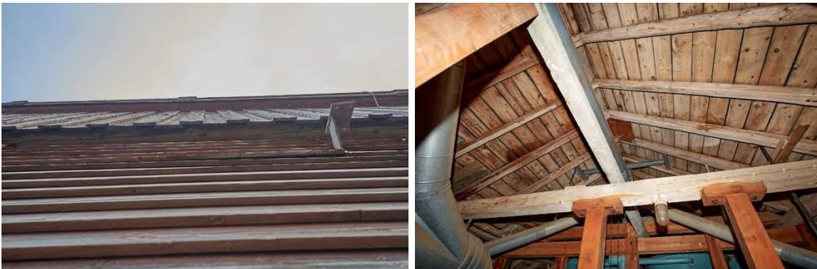
Links: Doppelverschalung, potenzielle Wochenstube; rechts: Dachstuhl des Sandsteingebäudes mit offenen Holzbalken und Brettverschalung (Uwe Scheurich, 15.08.22)
