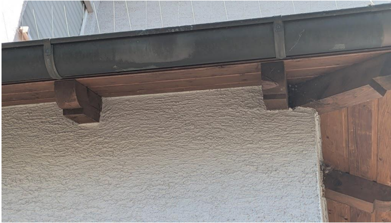
Abbildung 6: Die Detailansicht zeigt das vollständige Fehlen von Spalten.
