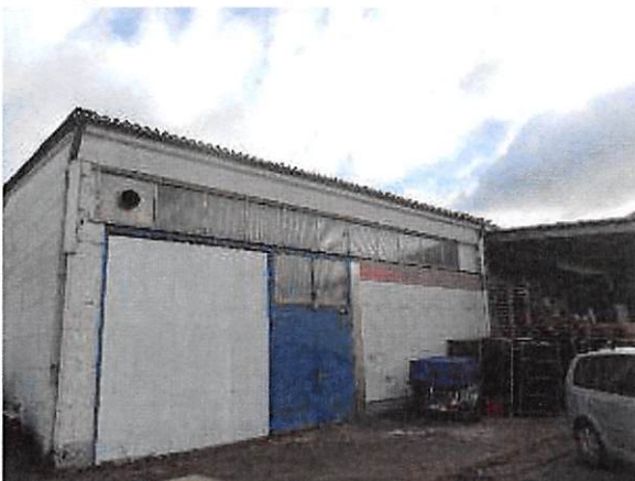
Westfassade der Hallen mit Be- und Entladerampen
