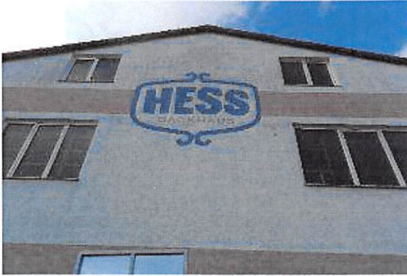
Nordöstliche Ansicht Wohngebäude
