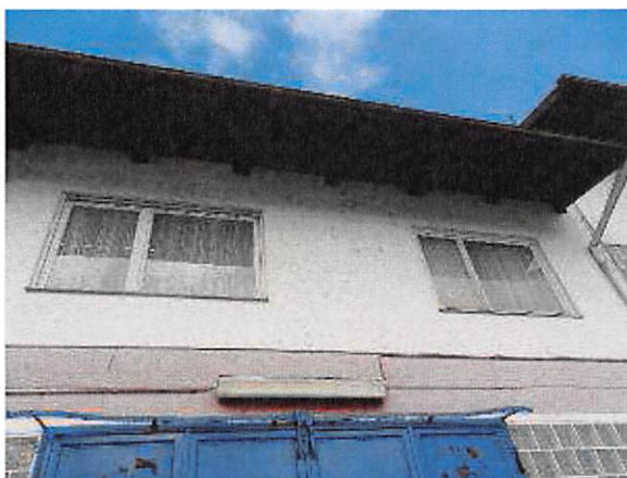
Südöstliche Ansicht Wohngebäude
