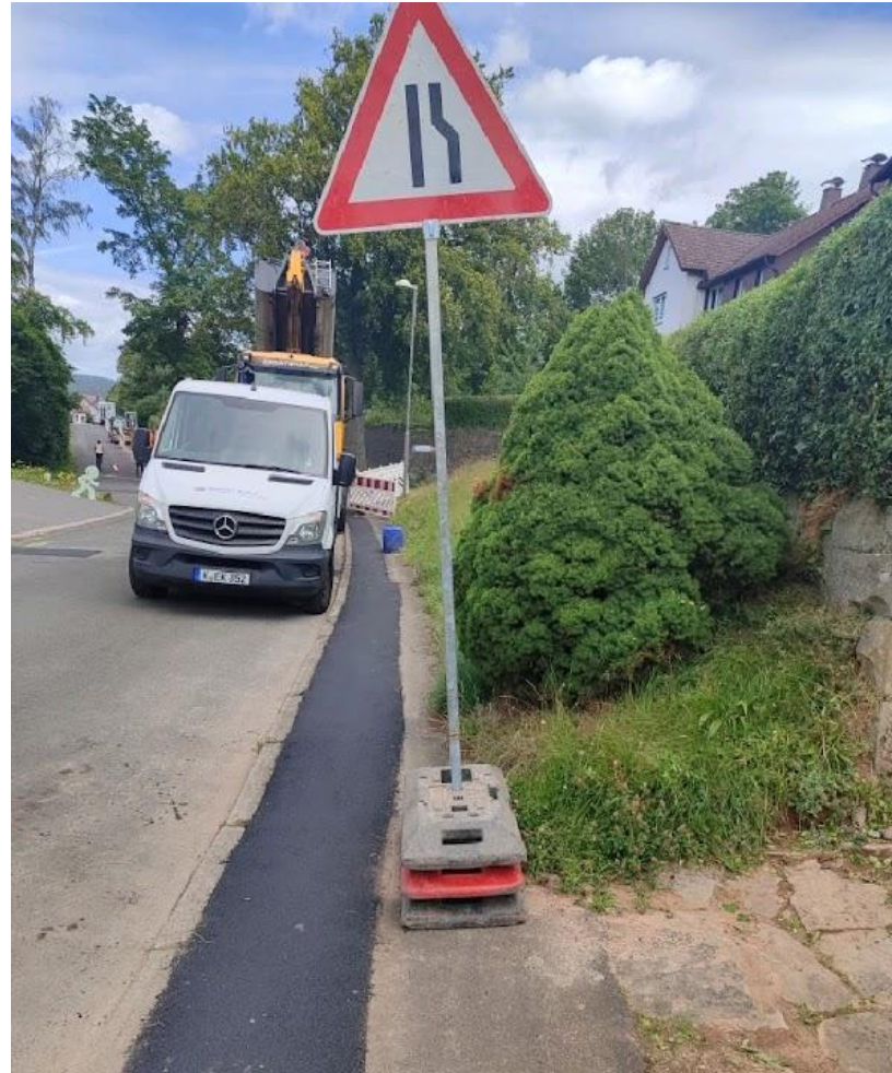
Feinschicht ein paar Tagen später eingebaut
