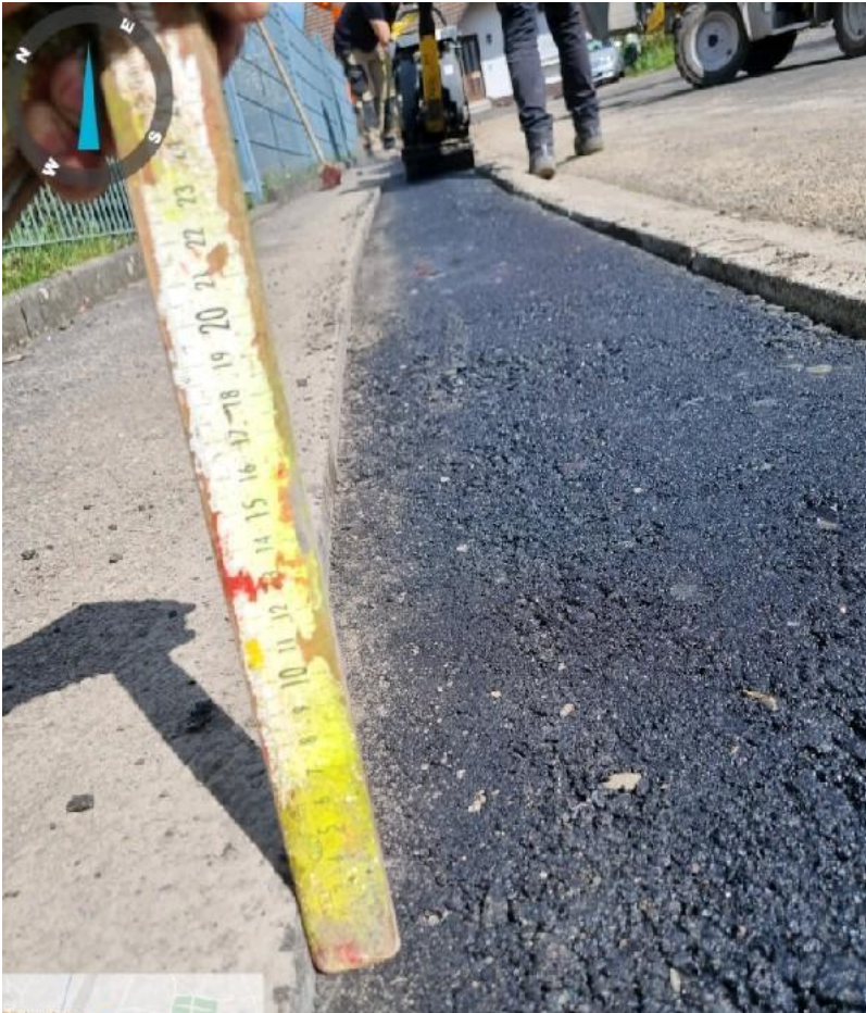
Tragschicht am selben Tag eingebaut
