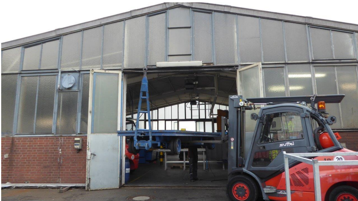
Abb. 6: Außenfassade der Lagerhalle
