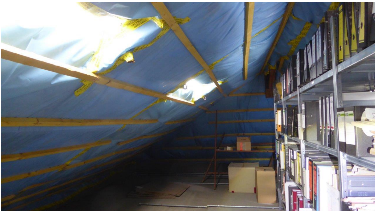
Abb. 8: Dachboden des zentralen Gebäudes
