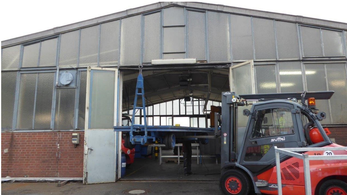
Abb. 6: Außenfassade der Lagerhalle
